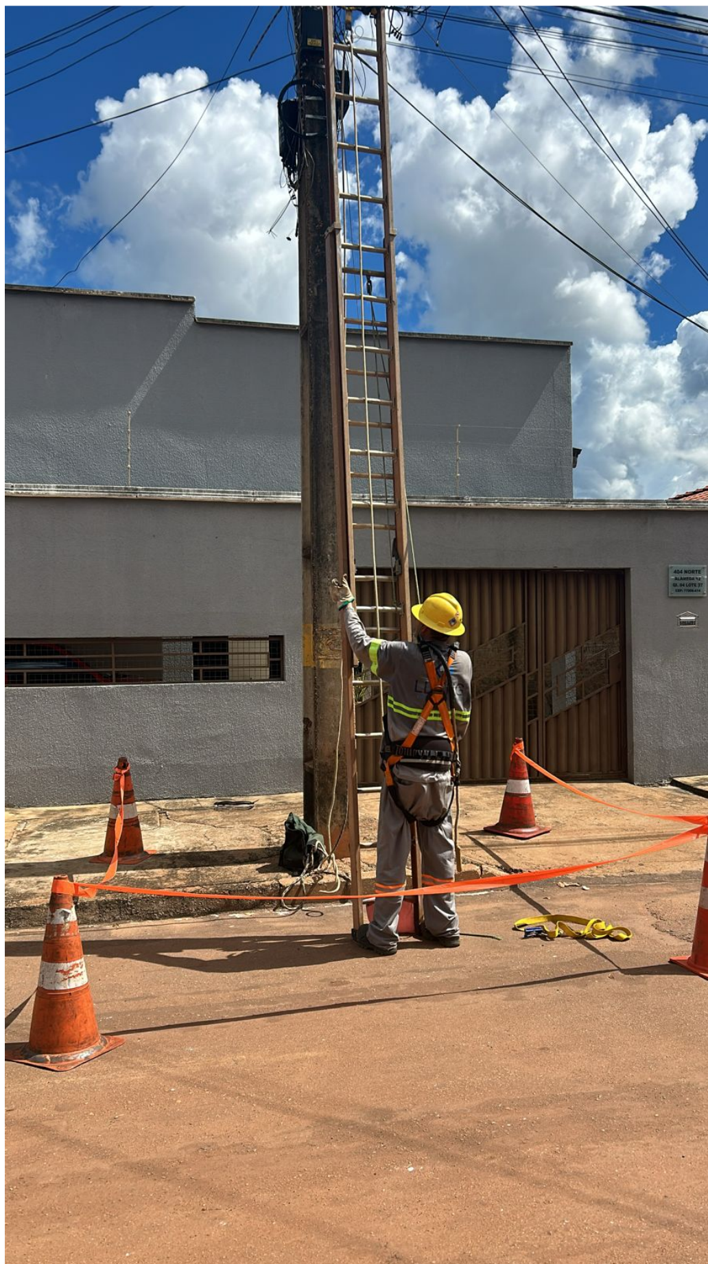
Figura 2 - Início da remoção de cabos da empresa de telecomunicações inadimplente. Fonte: A autora (2024)
